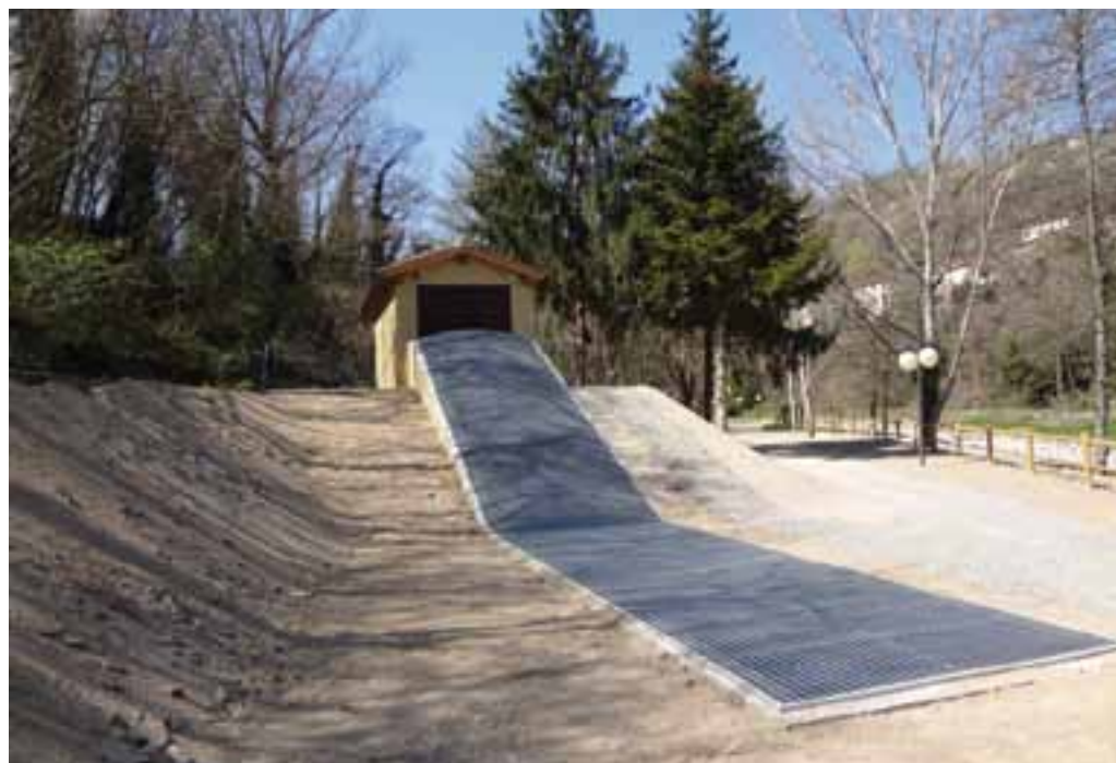
Impianto mini idroelettrico, Comune di Prato
