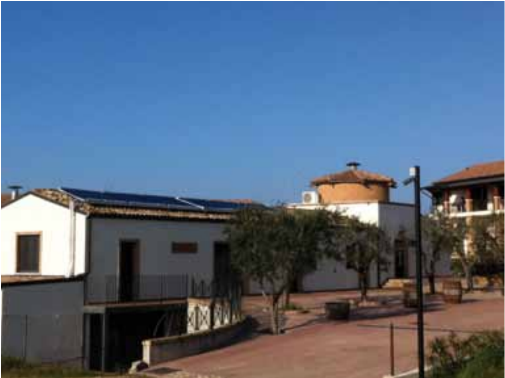
Impianto solare termico presso l'Agriturismo Masseria Casacapanna nel Comune di Cheuti (FG)
