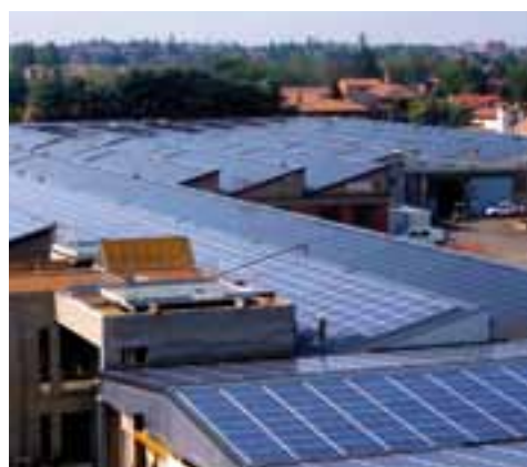
Impianti fotovoltaici, Comune di Castelvetro (MO)
