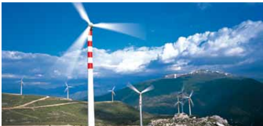
Impianto eolico Comune di Cocullo (AQ)
