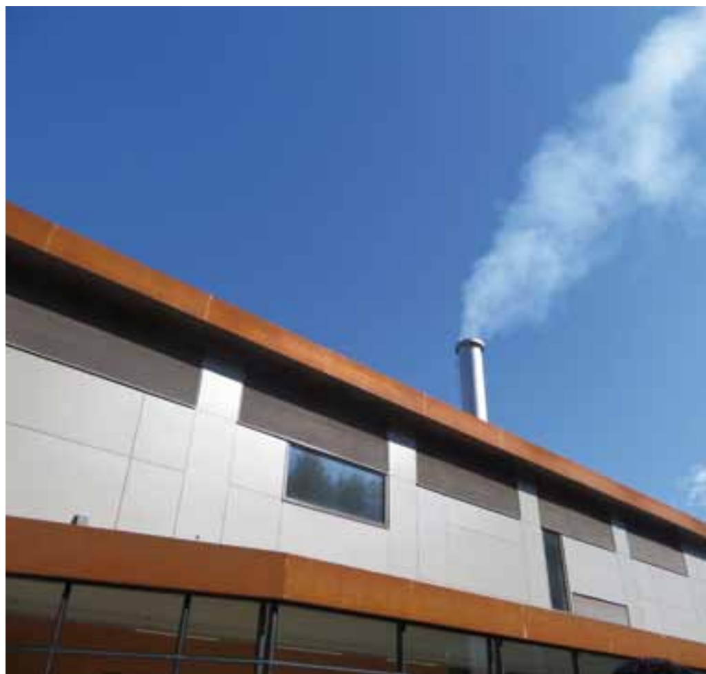
Impianto a biomassa Comune di Dobbiaco (BZ)
