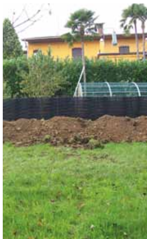
Impianto geotermico a bassa entalpia "a palizzata", Comune di Pralungo (BI)
