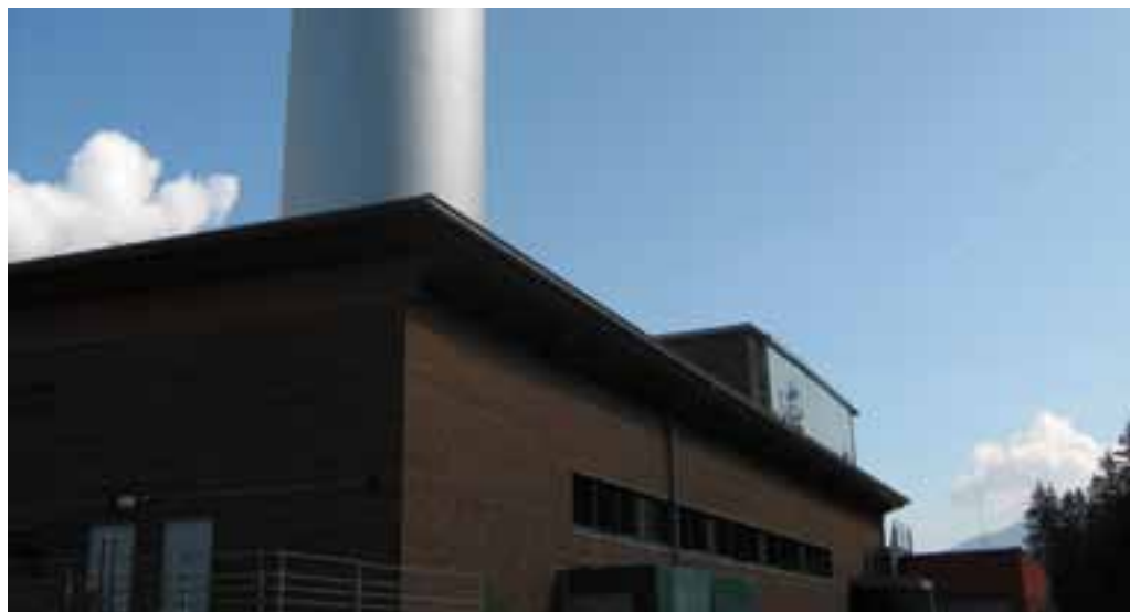
Impianto di teleriscaldamento, Comune di Dobbiaco (BZ)
