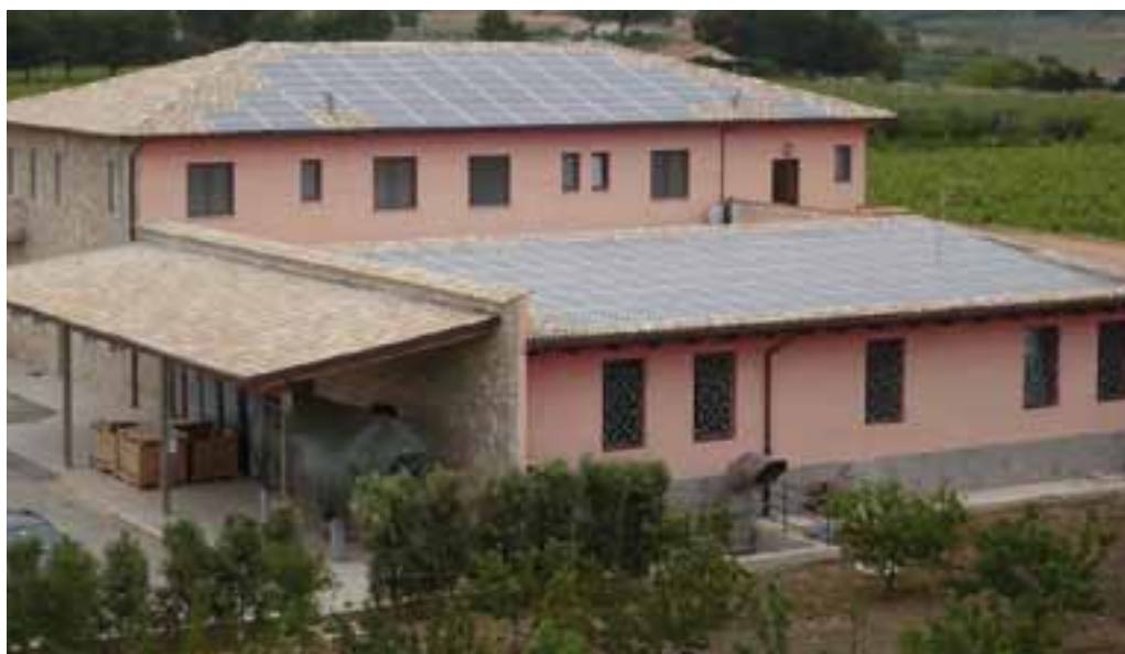
Impianto fotovoltaico Tenuta Menfi (AG)
