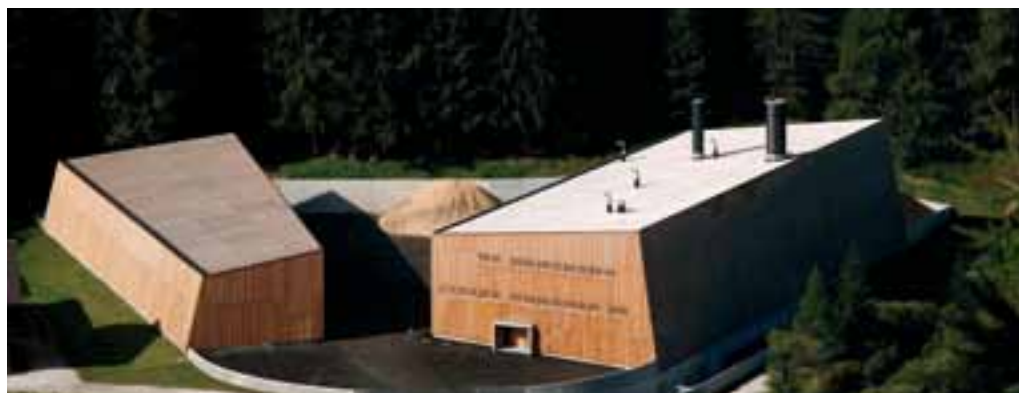
Impianto di teleriscaldamento nel Comune di Sesto (BZ)
